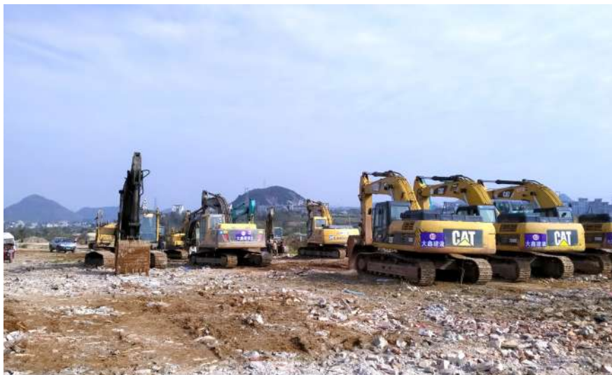
大型机械正在施工 记者 房泰安 摄
