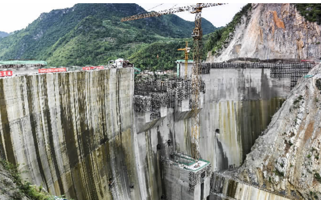
图为7月8日的兴义市马岭水利枢纽工程建设场景。
